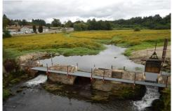
**Travaux d'effacement de 3 seuils** (barrages) sur la Tardoire, afin de restaurer totalement la continuité écologique, c'est-à-dire permettre le fonctionnement normal d'une rivière avec une libre migration des poissons et le transport naturel des sédiments. Les 3 seuils sont : moulin de la Barbarie (Oradour sur Vayres), moulin de Puybonland (Chéronnac) et moulin de Maisonnais. Les travaux ont eu lieu de septembre à décembre.
